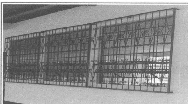
Foto 4: se observa los nuevos balcones instalados en el modulo 1
