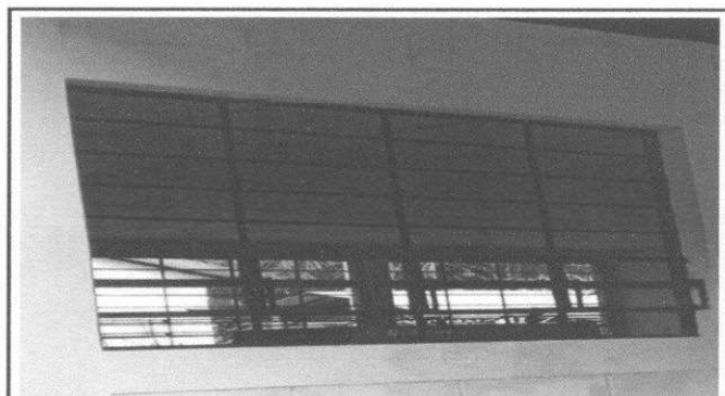
Foto 3: se observa el nuevo ventanario del modulo 1
