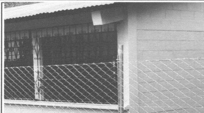
Foto 2: se observa la nueva pintura en las paredes en el modulo 1
